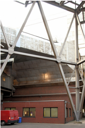
Kraftwerk Weisweiler: Elektrofilter von Kessel E1, Ansicht von Nordwesten; Foto: 16.06.2023 Fotograf/Urheber: Dr. Norbert Gilson
