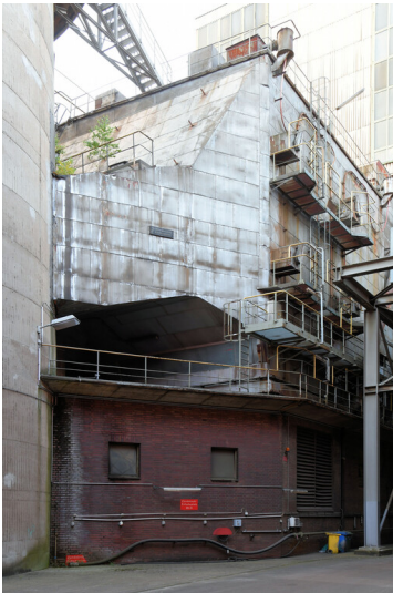
Kraftwerk Weisweiler: Elektrofilter von Kessel D, Ansicht von Norden; Foto: 16.06.2023 Fotograf/Urheber: Dr. Norbert Gilson
