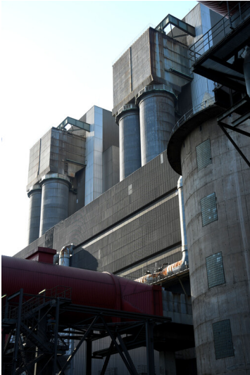
Kraftwerk Weisweiler: Kesselhaus Block G (rechts, links davon Block H), Ansicht von Nordwesten; Foto: 16.06.2023 Fotograf/Urheber: Dr. Norbert Gilson
