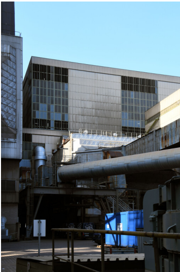
Kraftwerk Weisweiler: Kesselhaus Block F, Ansicht von Norden; Foto: 16.06.2023 Fotograf/Urheber: Dr. Norbert Gilson
