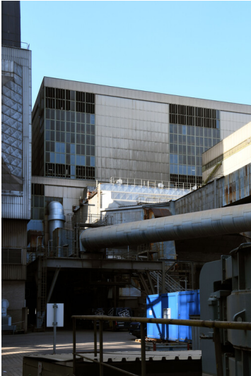
Kraftwerk Weisweiler: Kesselhaus Block F, Ansicht von Norden; Foto: 16.06.2023 Fotograf/Urheber: Dr. Norbert Gilson
