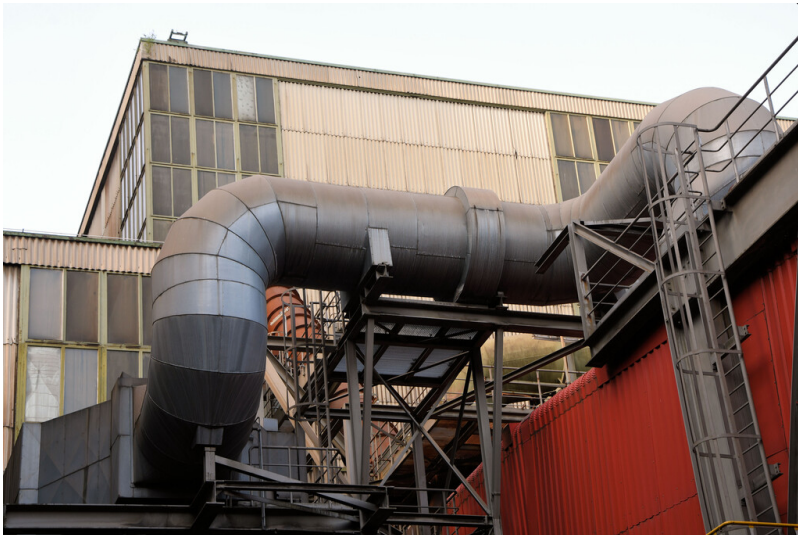
Kraftwerk Weisweiler: Kesselhaus Block E, Ansicht von Norden; Foto: 16.06.2023 Fotograf/Urheber: Dr. Norbert Gilson
