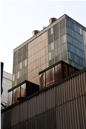
Kraftwerk Weisweiler: Kesselhaus Block D, Ansicht von Nordwesten; Foto: 16.06.2023 Fotograf/Urheber: Dr. Norbert Gilson
