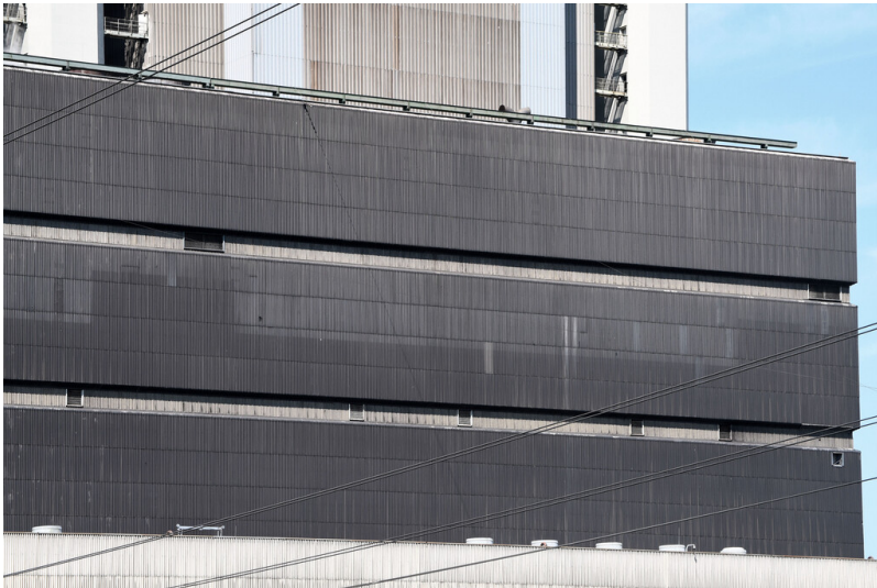
Kraftwerk Weisweiler: Schwerbau Block H, Ansicht von Südwesten; Foto: 13.06.2023 Fotograf/Urheber: Dr. Norbert Gilson
