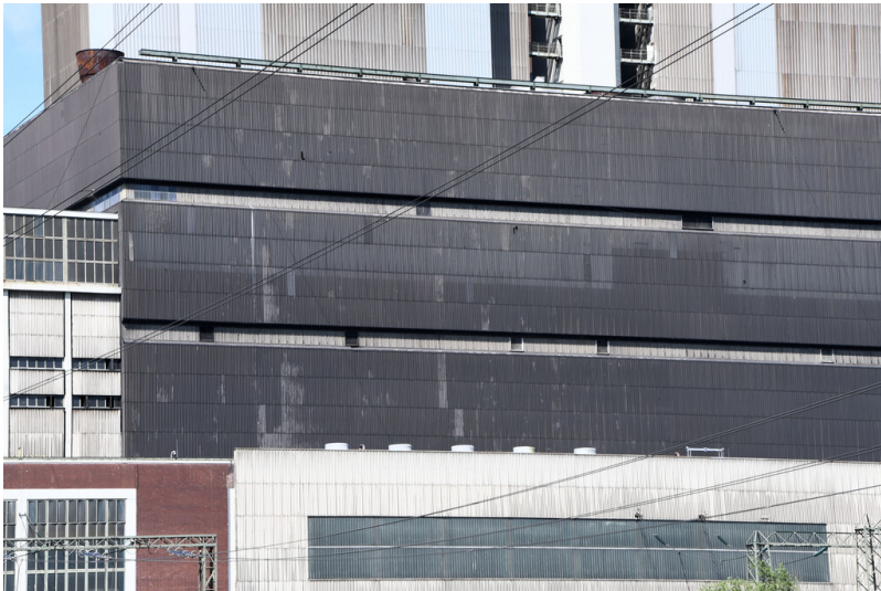
Kraftwerk Weisweiler: Schwerbau Block G, Ansicht von Südwesten; Foto: 13.06.2023 Fotograf/Urheber: Dr. Norbert Gilson
