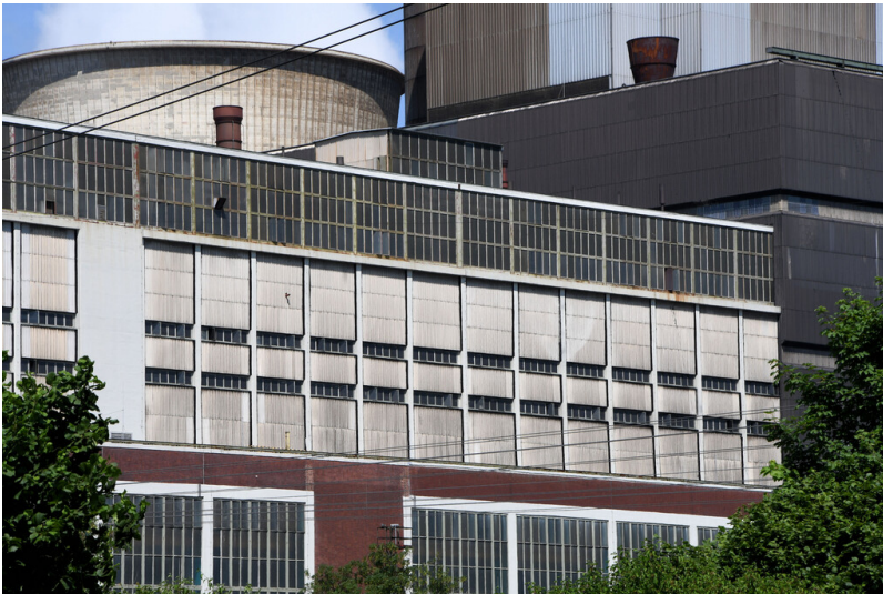
Kraftwerk Weisweiler: Schwerbau Block F, Ansicht von Süden; Foto: 13.06.2023 Fotograf/Urheber: Dr. Norbert Gilson
