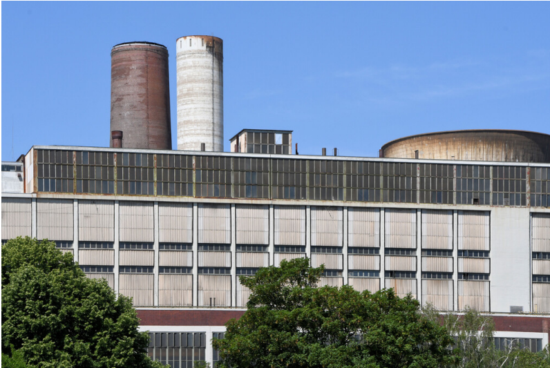
Kraftwerk Weisweiler: Schwerbau Block E, Ansicht von Süden; Foto: 13.06.2023 Fotograf/Urheber: Dr. Norbert Gilson
