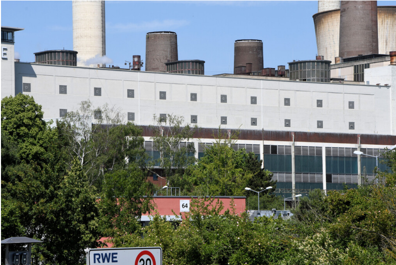
Kraftwerk Weisweiler: Schwerbau Blöcke A, B, C, Ansicht von Süden; Foto: 13.06.2023 Fotograf/Urheber: Dr. Norbert Gilson
