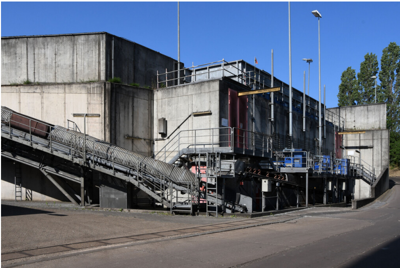
Kraftwerk Weisweiler: Papierschlamm-Mitverbrennung, Abzug des Papierschlammes aus dem Anlieferungsbunker, Ansicht von Osten; Foto: 13.06.2023 Fotograf/Urheber: Dr. Norbert Gilson
