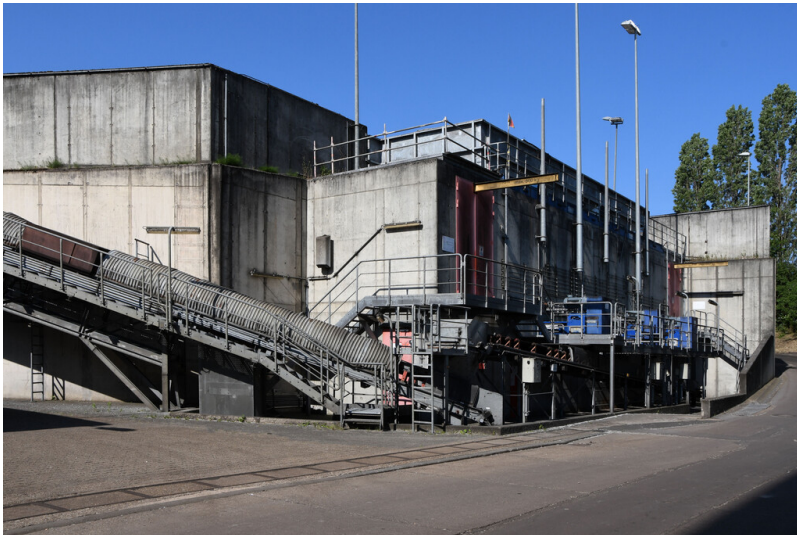
Kraftwerk Weisweiler: Papierschlamm-Mitverbrennung, Abzug des Papierschlamms aus dem Anlieferungsbunker, Ansicht von Osten; Foto: 13.06.2023 Fotograf/Urheber: Dr. Norbert Gilson
