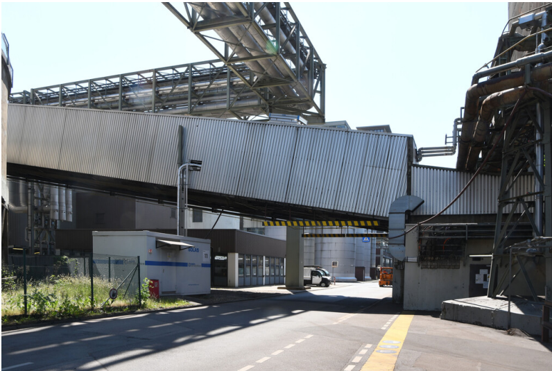
Kraftwerk Weisweiler: Bunkerband 5/6, Ausführung aus der Brecherei 5/6, Ansicht von Norden; Foto: 13.06.2023 Fotograf/Urheber: Dr. Norbert Gilson
