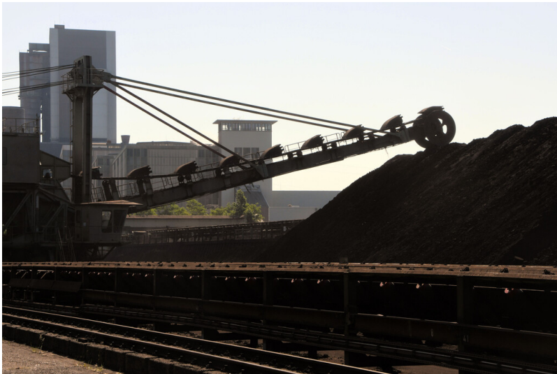
Kraftwerk Weisweiler: Eisenausscheidung 5/6 (im Hintergrund), Ansicht von Norden; Foto: 16.06.2023 Fotograf/Urheber: Dr. Norbert Gilson
