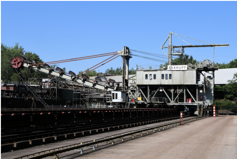
Kraftwerk Weisweiler: Grabenbunker 3, Bunkerbagger 6, Ansicht von Nordosten; Foto: 13.06.2023 Fotograf/Urheber: Dr. Norbert Gilson
