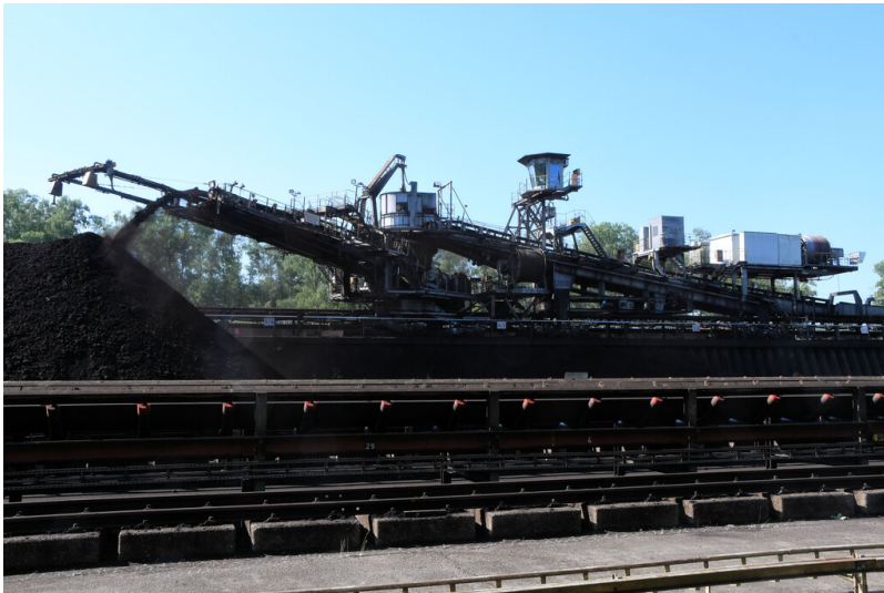
Kraftwerk Weisweiler: Grabenbunker 3, Bandschleifenwagen 981, Ansicht von Nordosten; Foto: 13.06.2023 Fotograf/Urheber: Dr. Norbert Gilson
