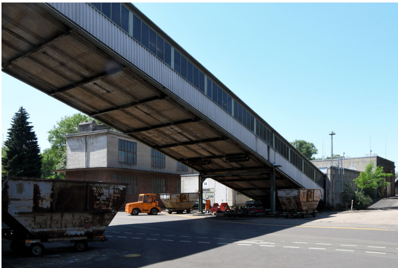
Kraftwerk Weisweiler: Bekohlungsbandbrücke, von Eisenausscheidung 3/4 abgehend, Ansicht von Nordosten; Foto: 13.06.2023 Fotograf/Urheber: Dr. Norbert Gilson
