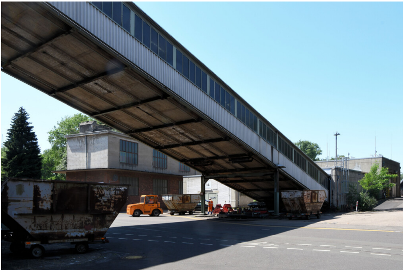
Kraftwerk Weisweiler: Bekohlungsbandbrücke, von Eisenausscheidung 3/4 abgehend, Ansicht von Nordosten; Foto: 13.06.2023 Fotograf/Urheber: Dr. Norbert Gilson
