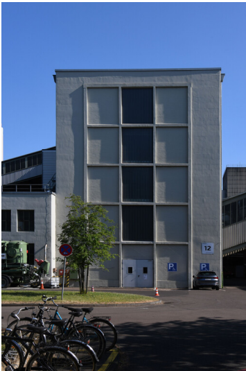
Kraftwerk Weisweiler: Brecherei 3/4, Altgebäude von 1954/55, Ansicht von Süden; Foto: 13.06.2023 Fotograf/Urheber: Dr. Norbert Gilson
