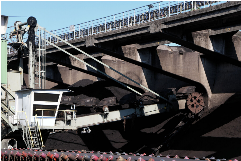
Kraftwerk Weisweiler: Bunkerbagger 3 in Grabenbunker 2, Tragarm mit durchhängender Eimerkette, Ansicht von Osten; Foto: 13.06.2023 Fotograf/Urheber: Dr. Norbert Gilson
