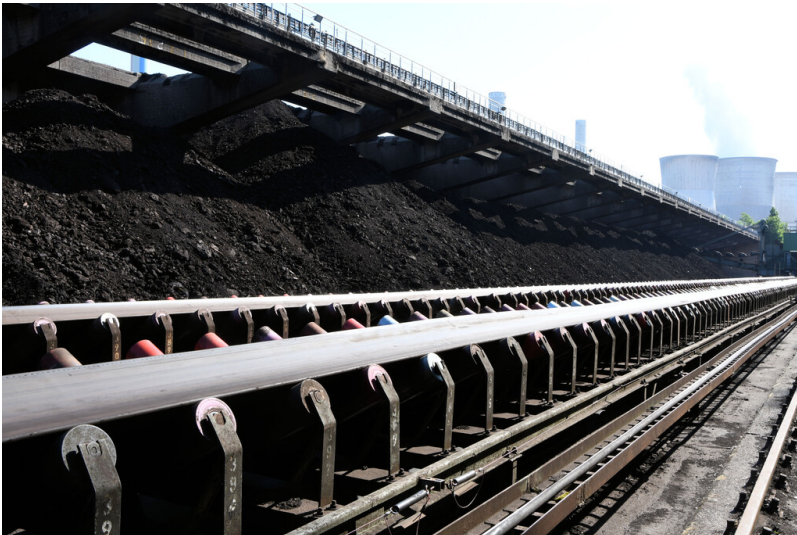
Kraftwerk Weisweiler: Grabenbunker 2, Kragarmkonstruktion, Kohlekegel und Bunkerbänder, Ansicht von Südwesten; Foto: 13.06.2023 Fotograf/Urheber: Dr. Norbert Gilson
