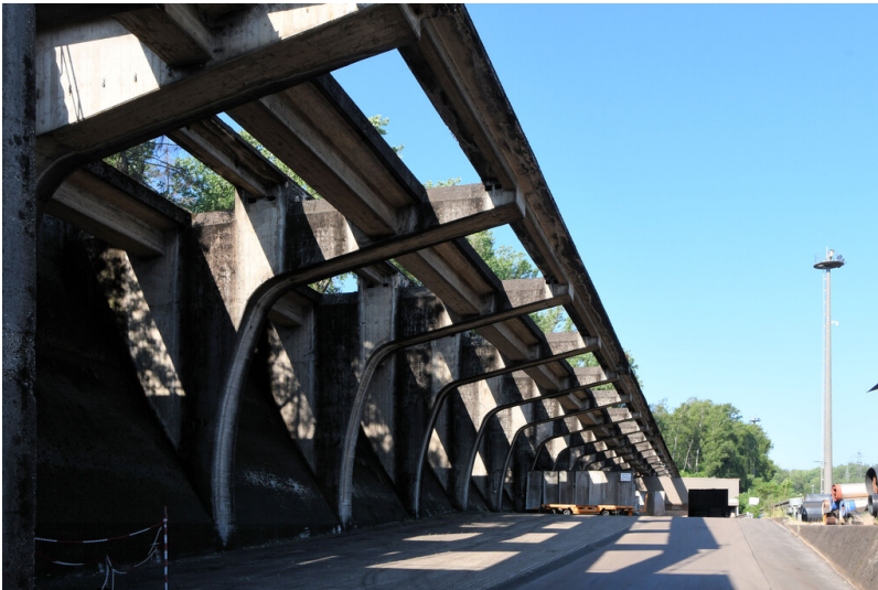
Kraftwerk Weisweiler: Grabenbunker I, Kragarmkonstruktion, Ansicht von Nordosten; Foto: 13.06.2023 Fotograf/Urheber: Dr. Norbert Gilson
