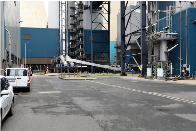
Kraftwerk Niederaußem: Werkstraßen rund um Block K, südwestlicher Straßenzug, Ansicht von Südosten; Foto: 15.08.2023 Fotograf/Urheber: Dr. Norbert Gilson
