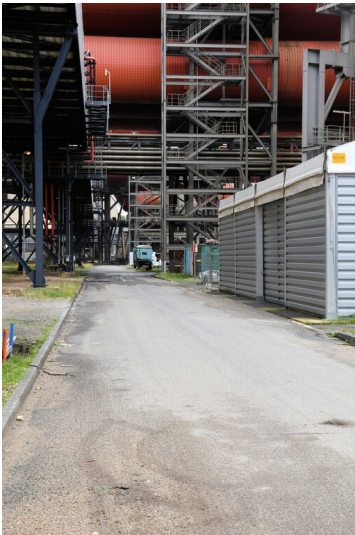
Kraftwerk Niederaußem: Kühlturmstraße, zwischen den Kühltürmen E und D, Ansicht von Südwesten; Foto: 15.08.2023 Fotograf/Urheber: Dr. Norbert Gilson
