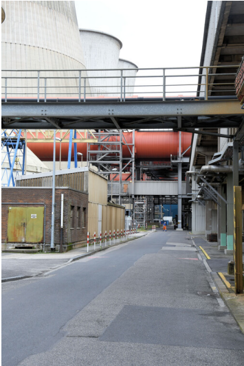
Kraftwerk Niederaußem: Kaminstraße, Ansicht von Südwesten; Foto: 15.08.2023 Fotograf/Urheber: Dr. Norbert Gilson
