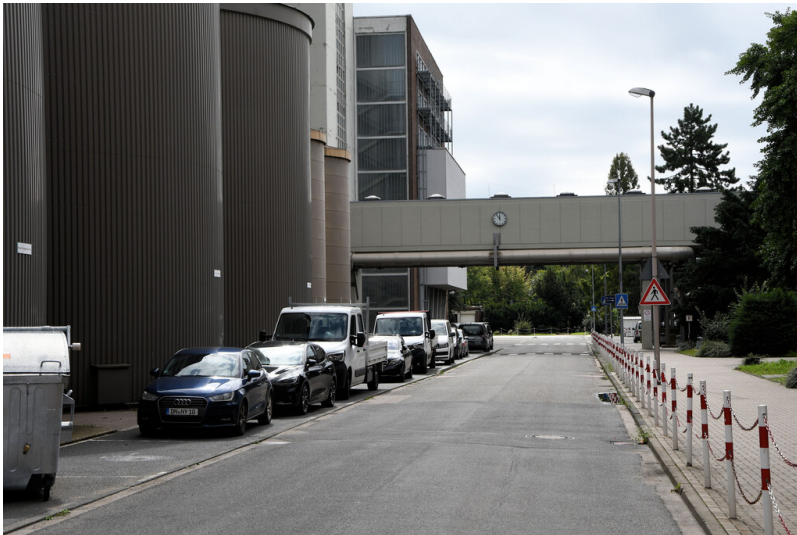
Kraftwerk Niederaußem: Bauhofstraße, Ansicht von Nordwesten; Foto: 15.08.2023 Fotograf/Urheber: Dr. Norbert Gilson
