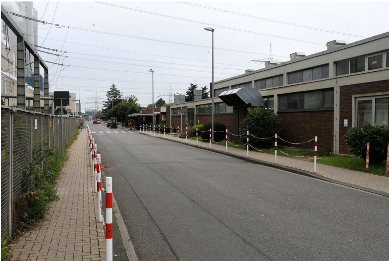
Kraftwerk Niederaußem: Trafostraße, Ansicht von Westen; Foto: 17.08.2023 Fotograf/Urheber: Dr. Norbert Gilson
