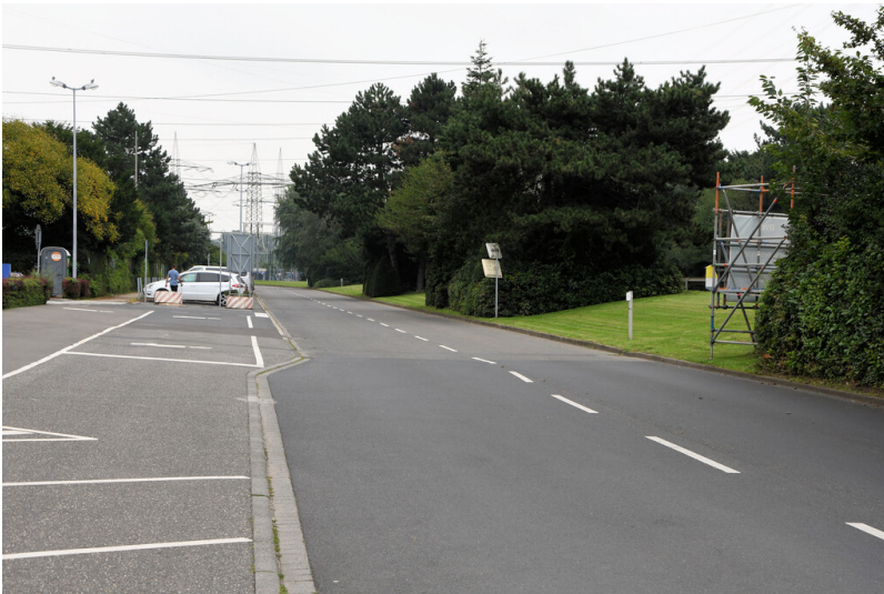
Kraftwerk Niederaußem: Zufahrtsstraße zum Kraftwerksgelände, Ansicht von Südwesten; Foto: 17.08.2023 Fotograf/Urheber: Dr. Norbert Gilson
