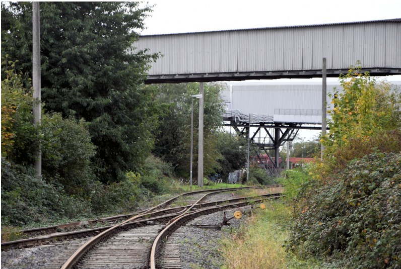
Kraftwerk Niederaußem: Zufahrtsgleis zum Lokschuppen, Abzweig des gemeinsamen Asche- und Lokschuppengleises (vorne im Bild) vom Schwerbau-, Maschinenhaus- und Trafogleis, Ansicht von Osten; Foto: 23.10.2023 Fotograf/Urheber: Dr. Norbert Gilson
