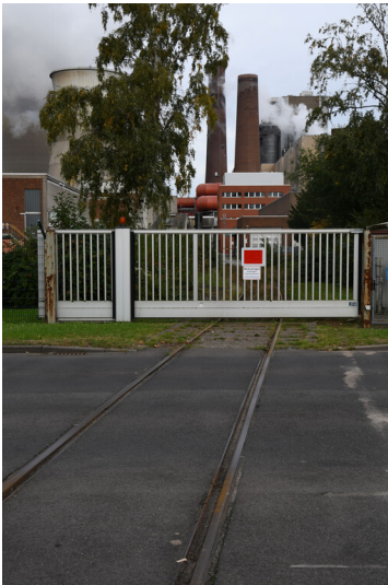
Kraftwerk Niederaußem: Aschegleis, Zufahrt auf das Kraftwerksgelände nach Kreuzung mit der Auenheimer Straße, Ansicht von Südwesten; Foto: 23.10.2023 Fotograf/Urheber: Dr. Norbert Gilson
