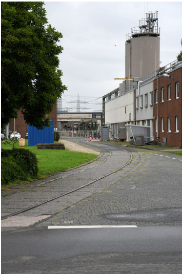
Kraftwerk Niederaußem: Trafogleis, zur Einfahrt zum Aufstellgelände der Maschinentransformatoren führend, Ansicht von Westen; Foto: 15.08.2023 Fotograf/Urheber: Dr. Norbert Gilson
