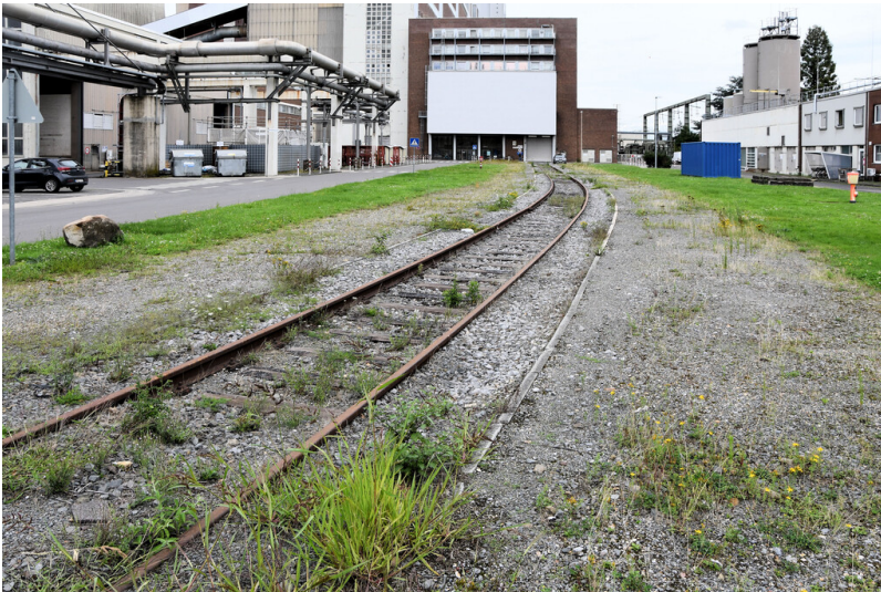
Kraftwerk Niederaußem: Maschinenhausgleis, Ansicht von Südwesten; Foto: 15.08.2023 Fotograf/Urheber: Dr. Norbert Gilson
