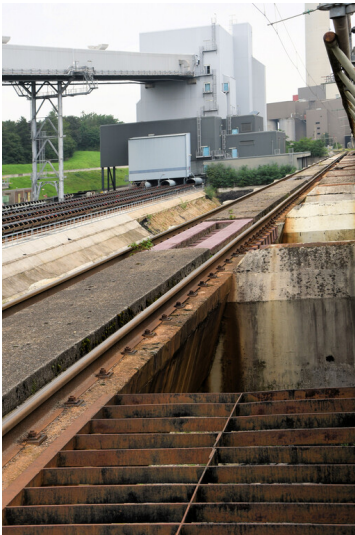
Kraftwerk Niederaußem: Bunkerbeschickungsgleise, nordwestliches Gleis auf den Bunkerkragarmen verlaufend, Ansicht von Südwesten; Foto: 17.08.2023 Fotograf/Urheber: Dr. Norbert Gilson
