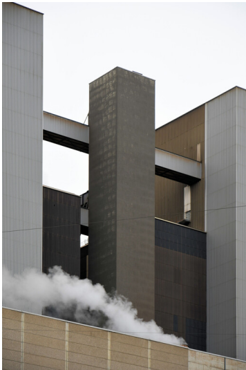
Kraftwerk Niederaußem: Fahrstuhl-Treppenhausturm von Block G, Ansicht von Süden; Foto: 23.10.2023 Fotograf/Urheber: Dr. Norbert Gilson
