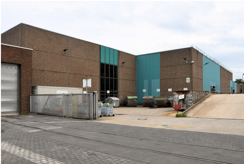
Kraftwerk Niederaußem: Lagergebäude, Ansicht von Westen; Foto: 15.08.2023 Fotograf/Urheber: Dr. Norbert Gilson
