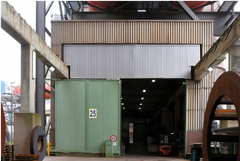
Kraftwerk Niederaußem: Mühlenwerkstatt G/H, Ansicht von Nordwesten; Foto: 15.08.2023 Fotograf/Urheber: Dr. Norbert Gilson
