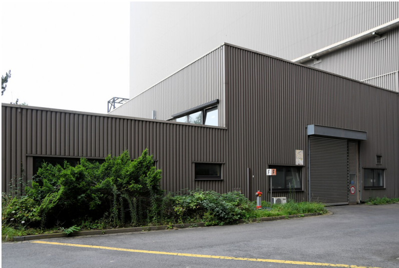
Kraftwerk Niederaußem: REA-Werkstatt mit Büros, Ansicht von Süden; Foto: 17.08.2023 Fotograf/Urheber: Dr. Norbert Gilson
