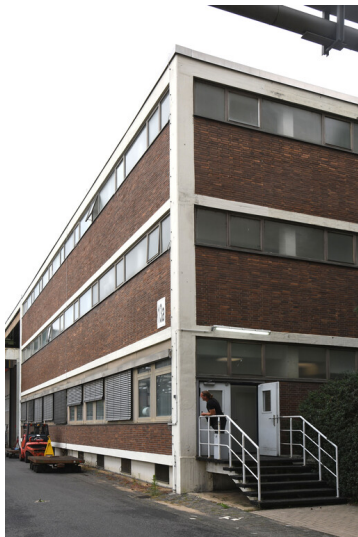
Kraftwerk Niederaußem: Waschkaue, Ansicht von Osten; Foto: 15.08.2023 Fotograf/Urheber: Dr. Norbert Gilson
