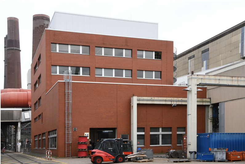
Kraftwerk Niederaußem: Multifunktionsgebäude, Ansicht von Südwesten; Foto: 15.08.2023 Fotograf/Urheber: Dr. Norbert Gilson
