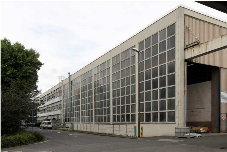
Kraftwerk Niederaußem: Hauptwerkstatt, Südwestfassade, Ansicht von Süden; Foto: 15.08.2023 Fotograf/Urheber: Dr. Norbert Gilson
