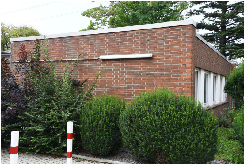
Kraftwerk Niederaußem: Alte Bauleitung Block D, südwestlicher Seitenflügel, Ansicht von Nordwesten; Foto: 17.08.2023 Fotograf/Urheber: Dr. Norbert Gilson
