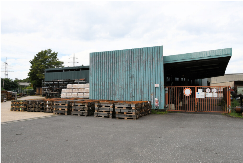
Kraftwerk Niederaußem: Außenlager, überdachter Lagerplatz, Schutzwand, Ansicht von Süden; Foto: 15.08.2023 Fotograf/Urheber: Dr. Norbert Gilson
