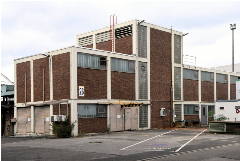
Kraftwerk Niederaußem: Filterhaus, Ansicht von Südosten; Foto: 15.08.2023 Fotograf/Urheber: Dr. Norbert Gilson
