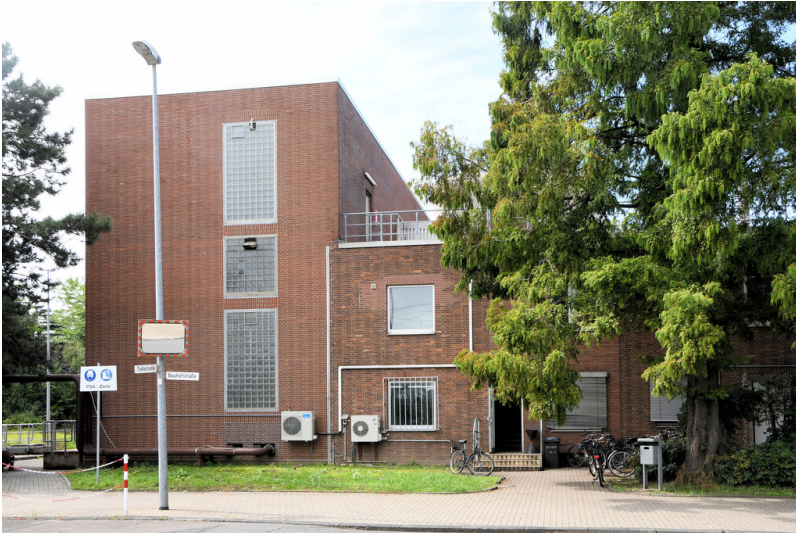
Kraftwerk Niederaußem: Wasseraufbereitungsanlage, Ansicht von Osten; Foto: 15.08.2023 Fotograf/Urheber: Dr. Norbert Gilson
