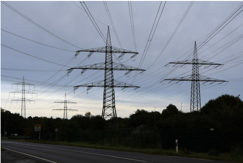
Kraftwerk Niederaußem: 400-kV-Hochspannungsfreileitung von Block K zur Umspannanlage Rommerskirchen, Abspannmast M 3 und Tragmast M 4 (Bl-Nr. 4589, Trasse links im Bild), ebenfalls mit Führung der Hochspannungsleitungen der Blöcke F, G und H, Ansicht von Südwesten; Foto: 23.10.2023 Fotograf/Urheber: Dr. Norbert Gilson
