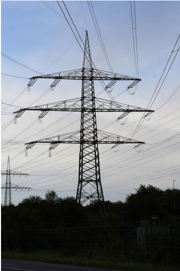
Kraftwerk Niederaußem: 380-kV-Hochspannungsfreileitung von Block G in Richtung Umspannanlage Rommerskirchen, auf Abspannmast M 3 auf der mittleren rechten Traverse (linkes Leitungsseil) und der oberen rechten Traverse (BI-Nr. 4589, gemeinsam mit den Leitungen der Blöcke F, H und K) geführt, Ansicht von Südwesten; Foto: 23.10.2023 Fotograf/Urheber: Dr. Norbert Gilson
