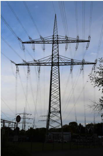
Kraftwerk Niederaußem: Hochspannungsfreileitung von Block E, auf oberer Traverse (linke Seite) von Abspannmast M 3 (BL-Nr. 4548) geführt, Ansicht von Westen; Foto: 23.10.2023 Fotograf/Urheber: Dr. Norbert Gilson
