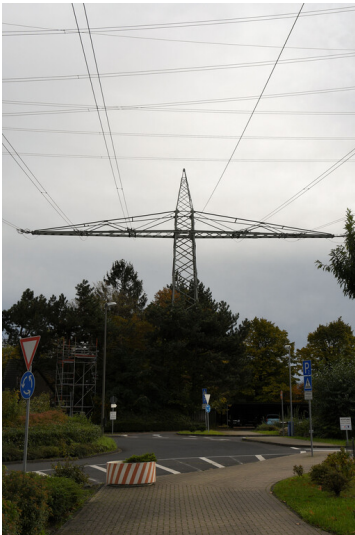
Kraftwerk Niederaußem: Freileitungsabgang Blöcke A/B, Führung der Leitungsseile auf den Abspannmast M 1A (BL-Nr. 4548), Ansicht von Nordwesten; Foto: 23.10.2023 Fotograf/Urheber: Dr. Norbert Gilson
