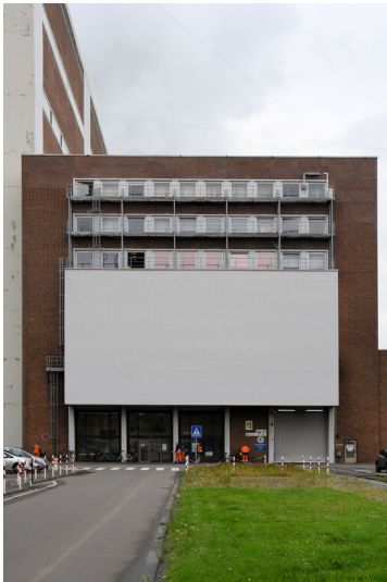
Kraftwerk Niederaußem: Maschinenhausvorbau, Ansicht von Westen; Foto: 15.08.2023 Fotograf/Urheber: Dr. Norbert Gilson
