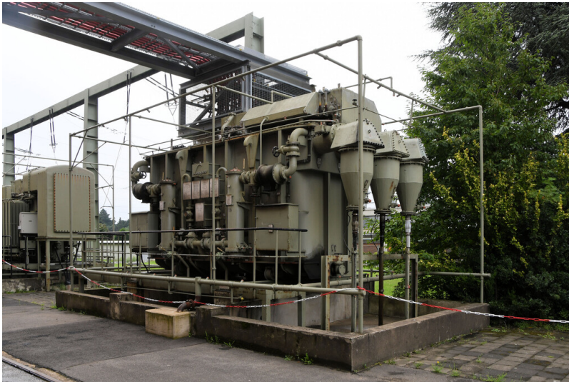
Kraftwerk Niederaußem: Anfahrtrafo 11 (110/6 kV, 40 MVA), Ansicht von Nordwesten; Foto: 17.08.2023 Fotograf/Urheber: Dr. Norbert Gilson
