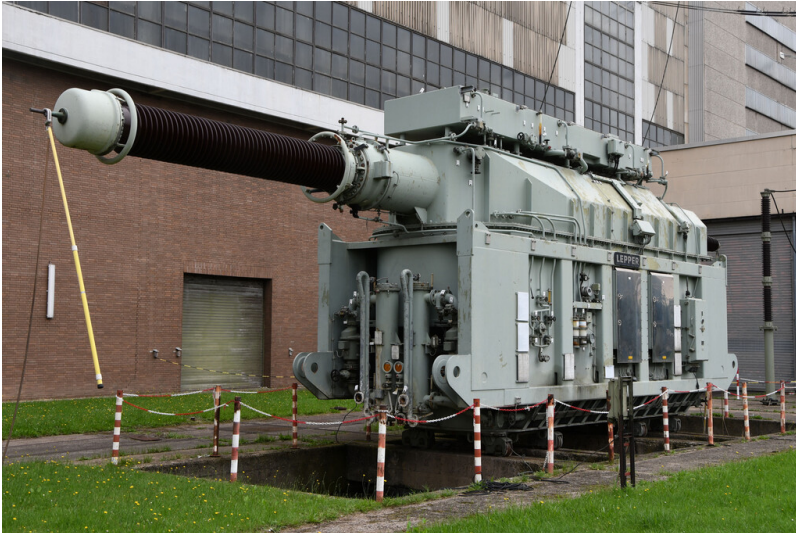
Kraftwerk Niederaußem: Transformatorenfeld Block F, Einphasen-Maschinentrafo (außer Betrieb), Ansicht von Südwesten; Foto: 17.08.2023 Fotograf/Urheber: Dr. Norbert Gilson
